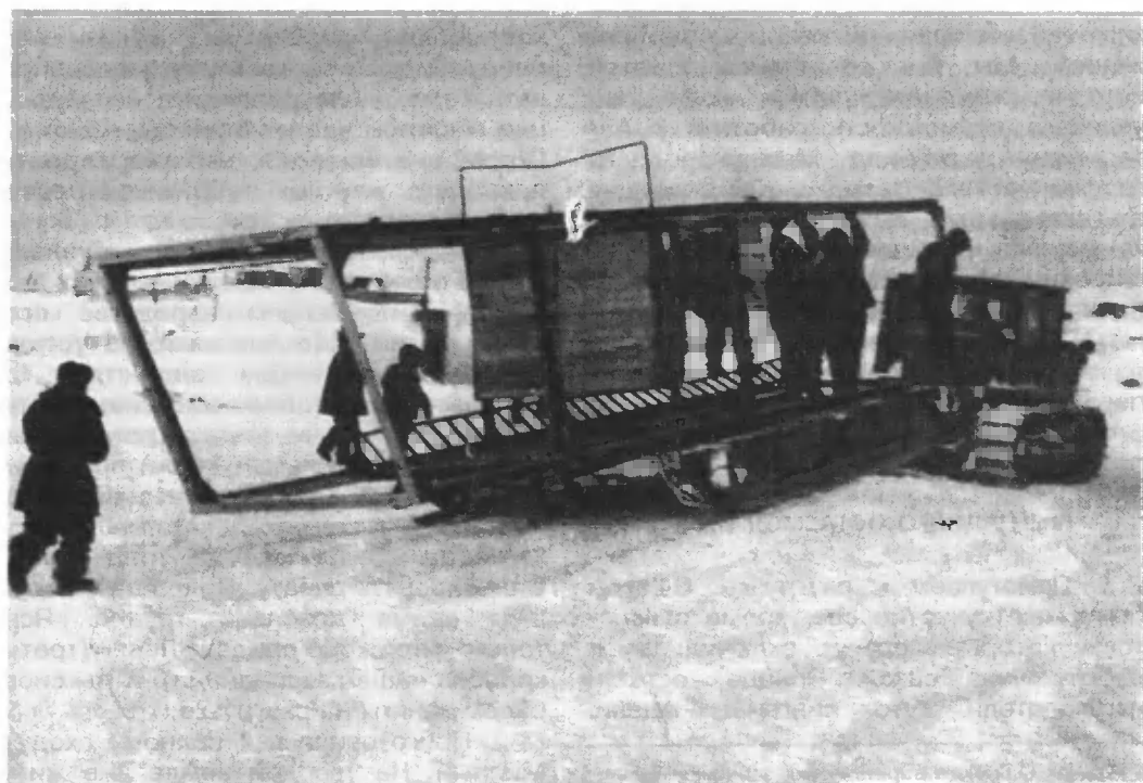
Транспортировка каркаса аэрологической вышки.
