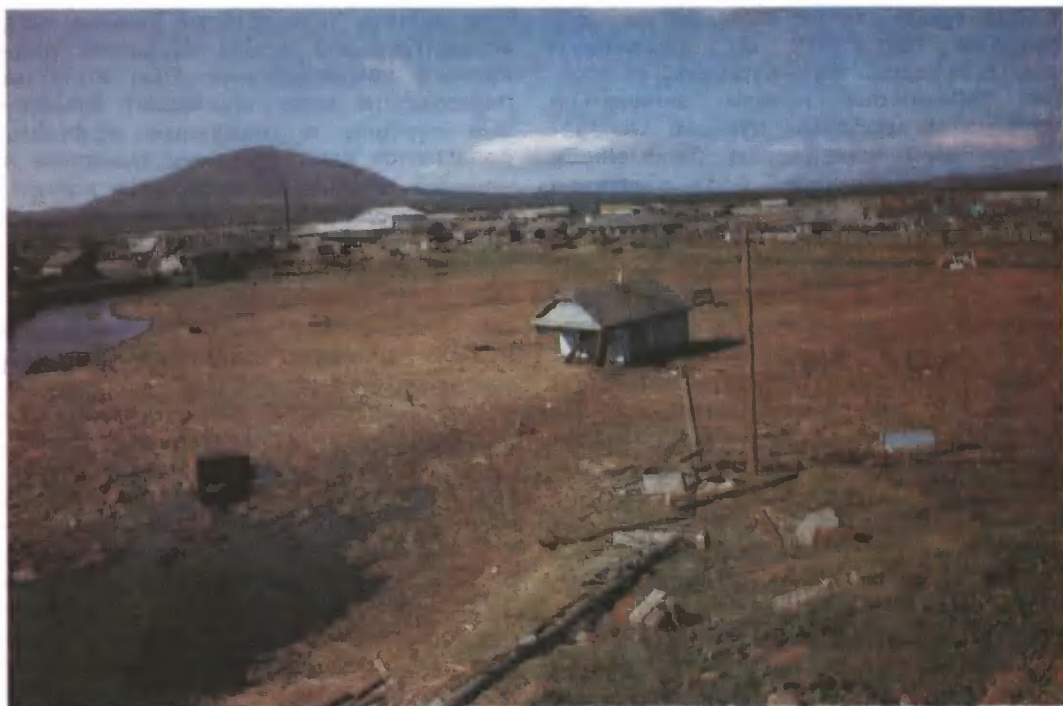
Жилой дом, перемещенный волной цунами на 300 м. Южно-Курильск, 4 октября 1994 г.
